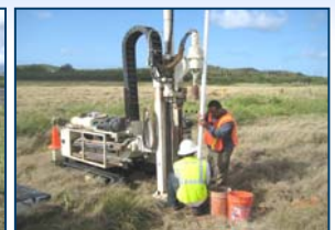
SWMU 56 – Excavadores de GeoEnviroTech están instalando un pozo de monitoreo de agua subterránea
