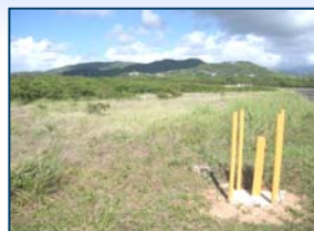
SWMU 69 – Pozo de monitoreo de agua subterránea instalado a lo largo del área de estacionamiento de aviones
