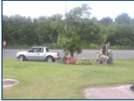
SWMU 71 – Excavadores de GeoEnviroTech están instalando un pozo de monitoreo de agua subterránea
